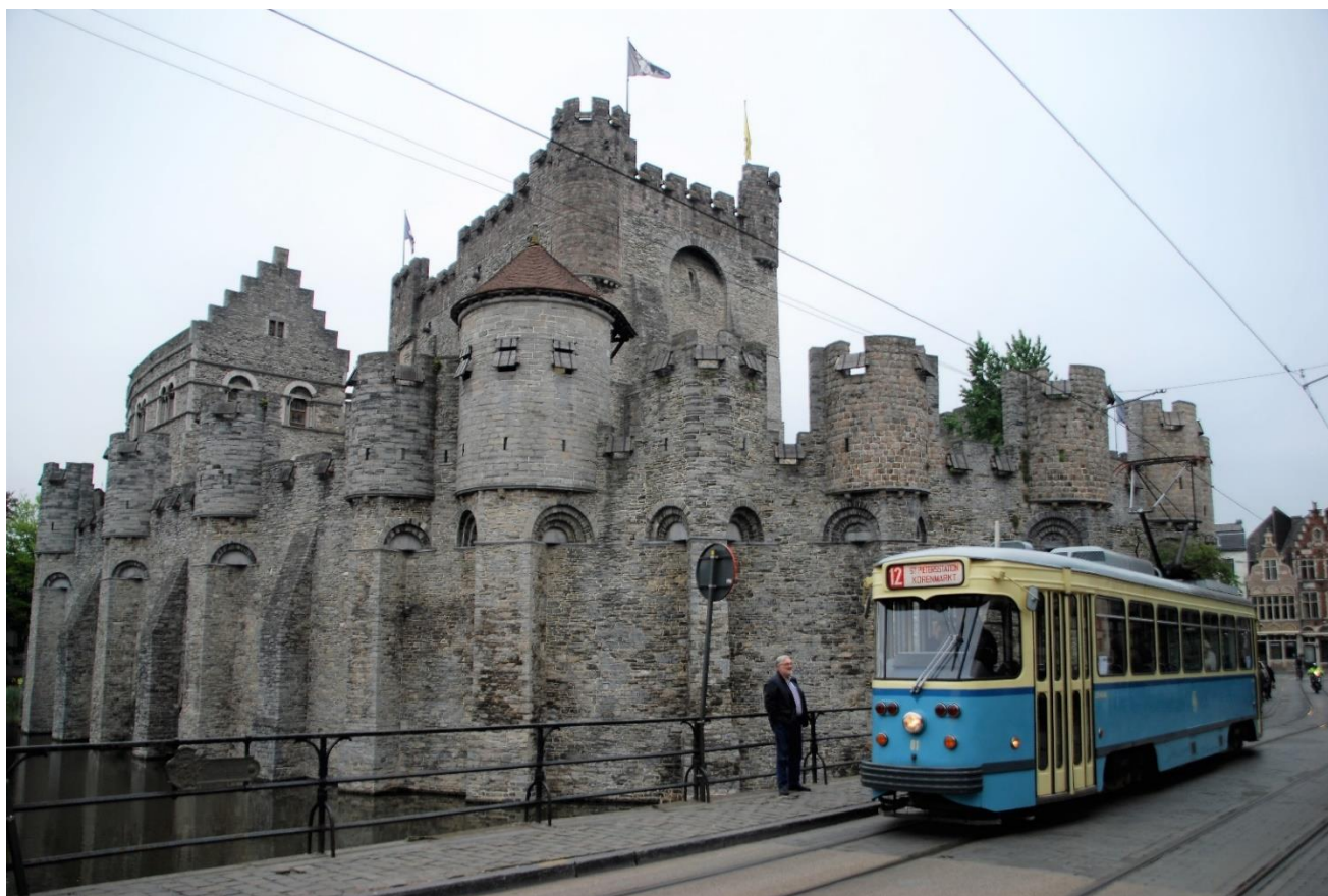
La 1ère PCC gantoise remise en livrée d'origine devant le mythique château des Comtes
