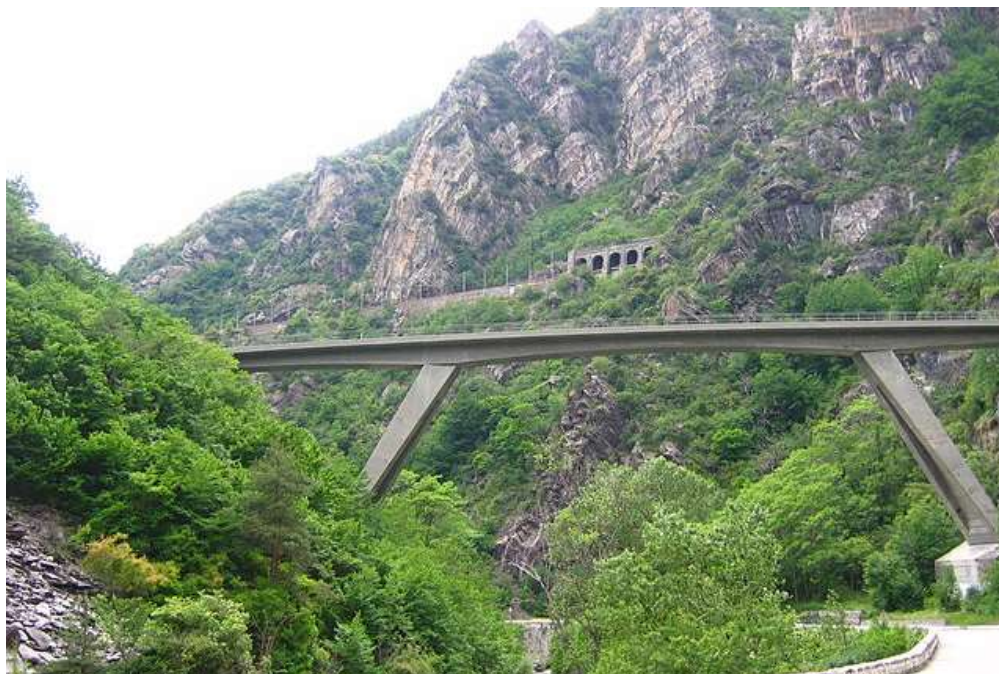
Le viaduc de Scarassoui, construit en 1978, sur la ligne ferroviaire de la Tende Rainer de Witten (Razi57), CC BY-SA 3.0, via Wikimedia Commons
